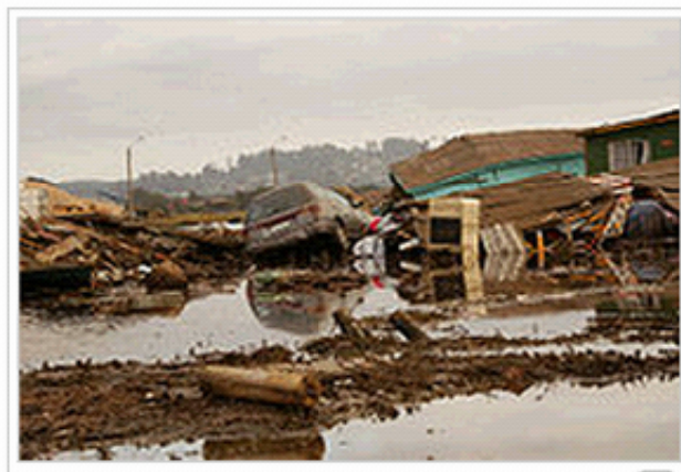
Dégâts au Chili suite au tsunami.
